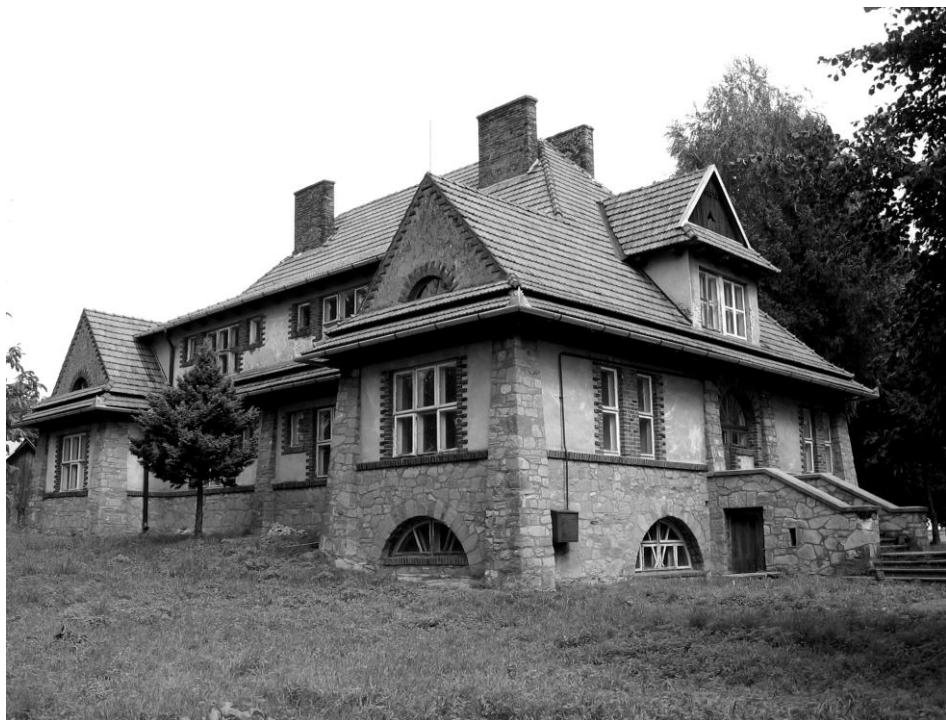
Wiejski Uniwersytet Orkanowy w Gaci. Budynek projektu Jana Witkiewicza (Koszyca), wybudowany społecznie w latach 1934–1936 (fot. K.M. Cwynar, 2011).
